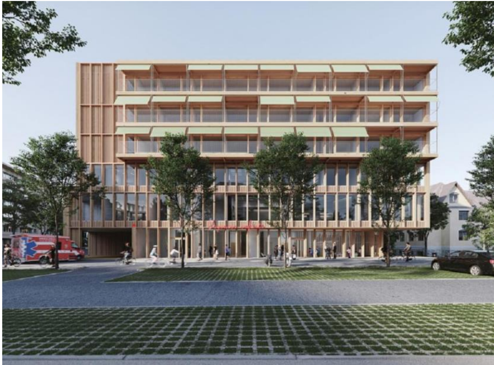
Futur Hôpital des enfants. Début des travaux 2025, ouverture prévue 2031
